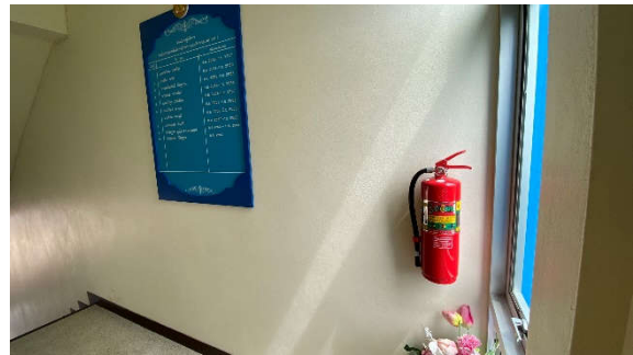
การติดตั้งถังดับเพลิงภายในอาคารสำนักงาน
